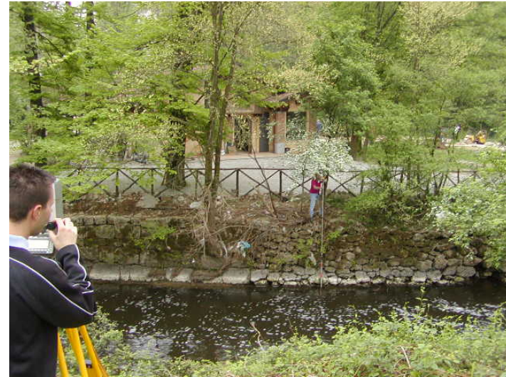
Foto 2: Rilievo topografico sezione A
