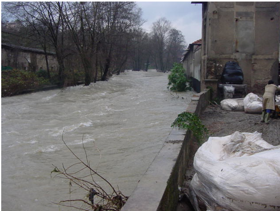
Foto 16: Tratto d'alveo a lato di via Vigano' (in primo piano il muro arginale superato dalle acque durante il picco della piena dell' 11/2002)
